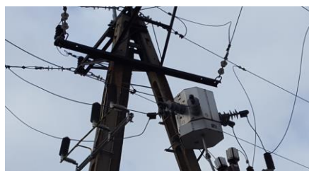
Rozłączniki napowietrzne SN -1180 szt.
